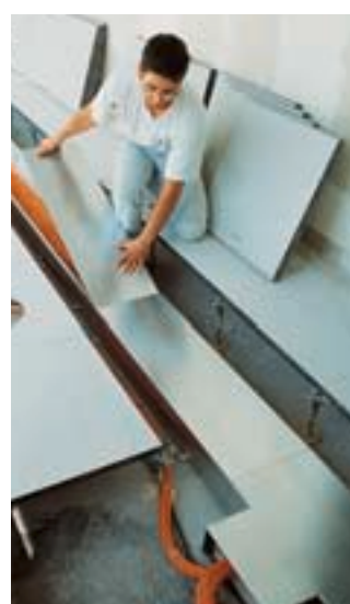
Каналы системы FWK всегда доступны для осуществления технического обслуживания или прокладки дополнительных проводов
